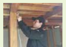
ケーブル配線の様子
