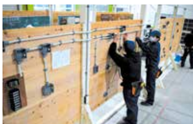
合成樹脂管工事作業
