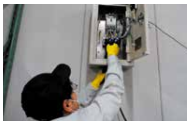
動力配線工事実習
