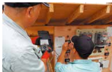
電気メーターの検査実習
