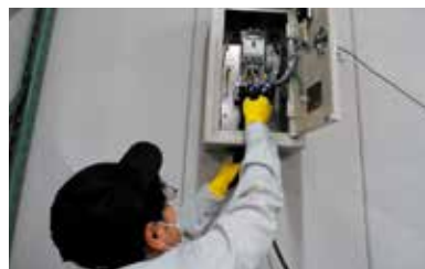
動力配線工事実習
