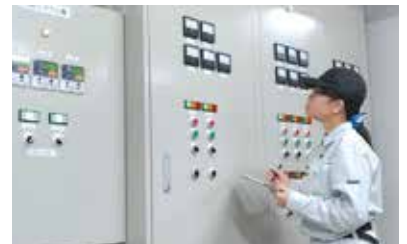
空調設備運転実習
