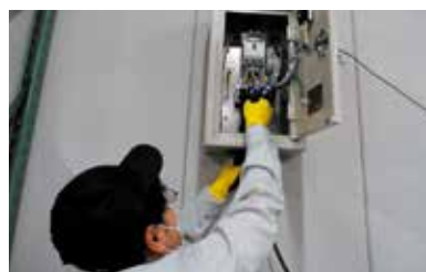
動力配線工事実習
